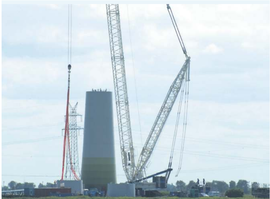
Grosse Windkraftanlagen erfordern schweres Gerät für den Aufbau, hier eine Baustelle in Ostfriesland vor einigen Jahren.
