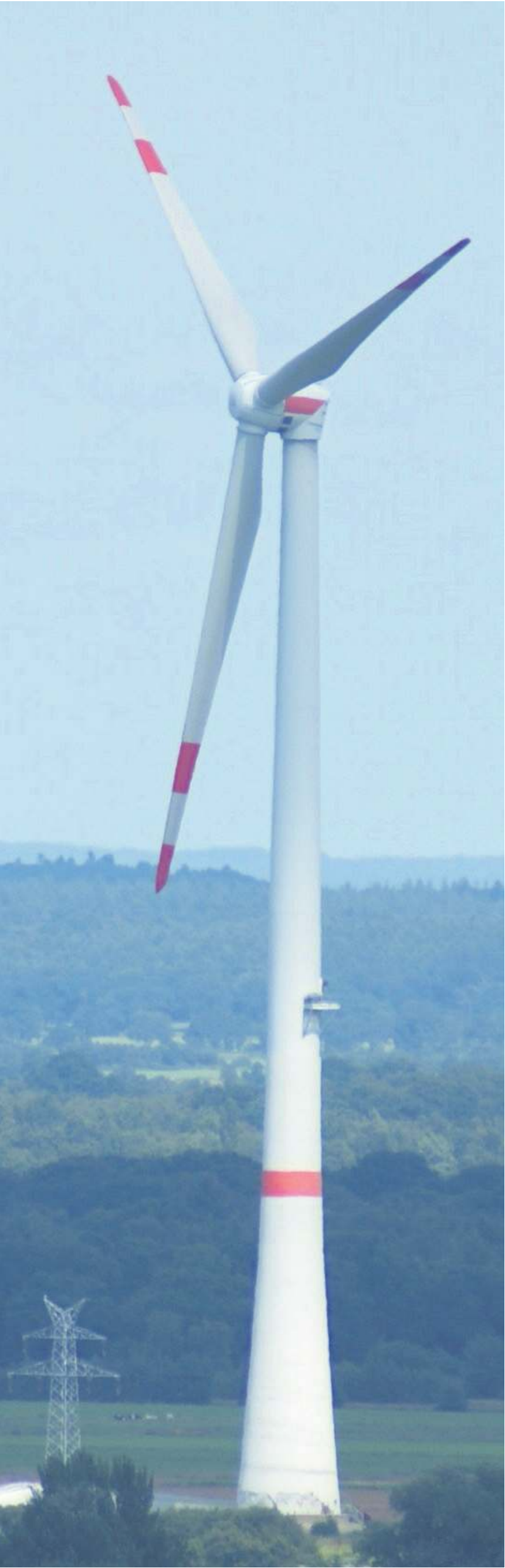
Die Gesamthöhe der Windenergieanlagen setzt sich aus der Turmhöhe und der Rotorblattlänge zusammen. Als Nabenhöhe bezeichnet man die Höhe der Rotornabe, um die sich der Rotor dreht.
